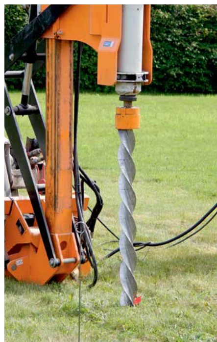
Einrammen der Gewindepfähle Pile-driving
