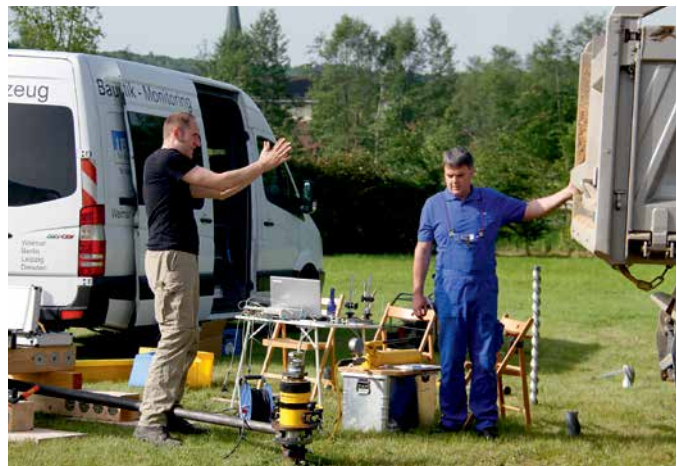
Pfahlprobelbelastung im Versuchsfeld | Pile load test in the test area
